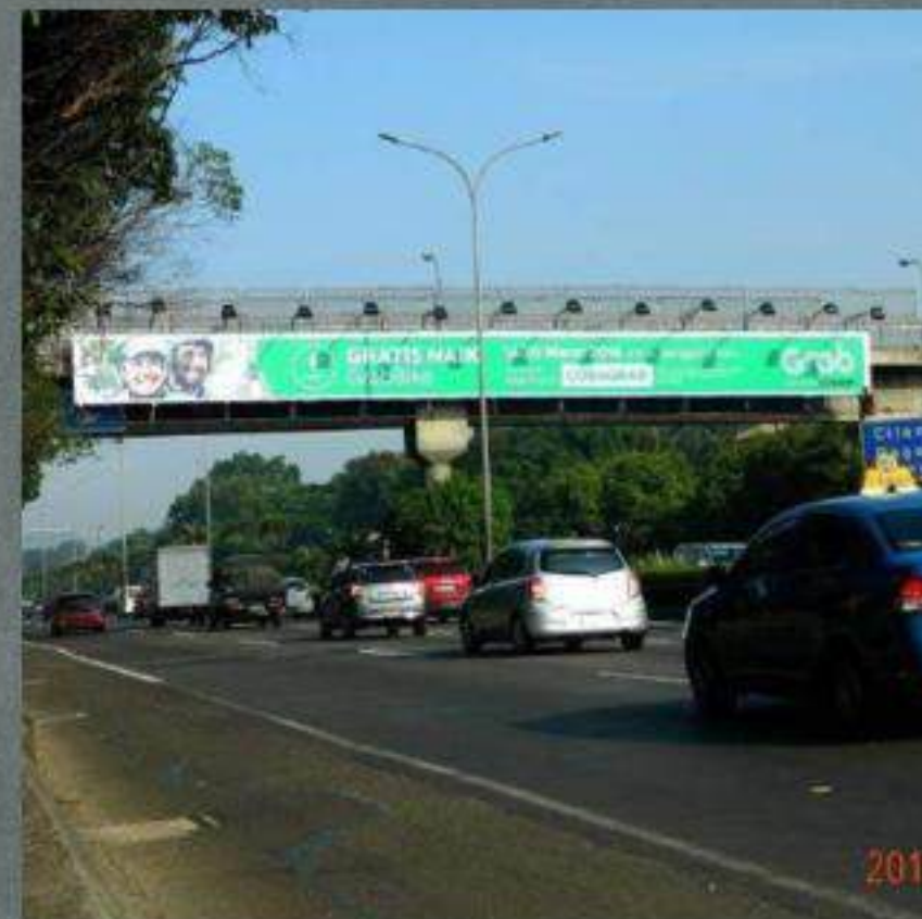
JPO JORR KM 26+500 JAKARTA SELATAN
